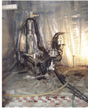
Fig. 6 - Fase de furação para inserção de microestacas - lintel interior
