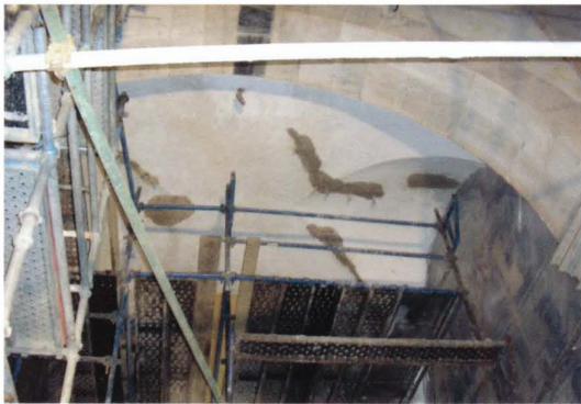
Fig. 7 - Consolidação de tectos por injeção controlada de calda - capela lateral
