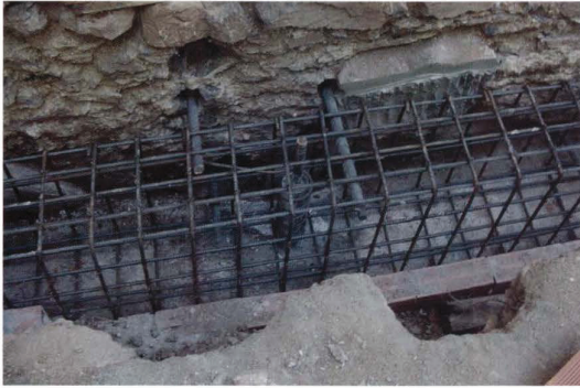
Fig. 5 - Montagem de armadura resistente e confinadores transversais em lintel de fundação, após execução de microestacas
