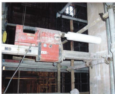
Fig. 9 - Reforço de pilastras por pregagens resistentes ocultas - fase de furação com caroteadora
